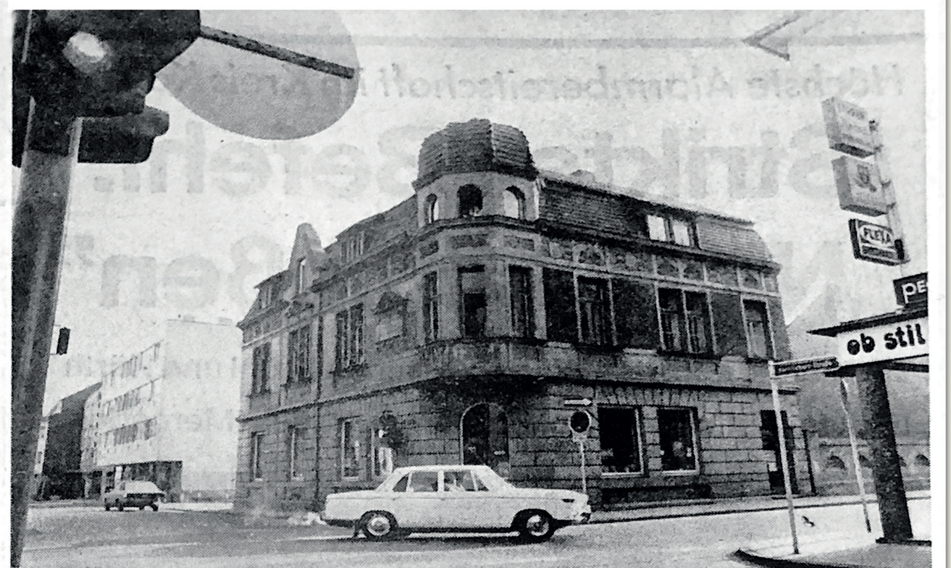
Die alte Stadtbücherei in Brühl wird in die Nähe des KBE-Bahnhofs verlegt. Foto: Tillmann
