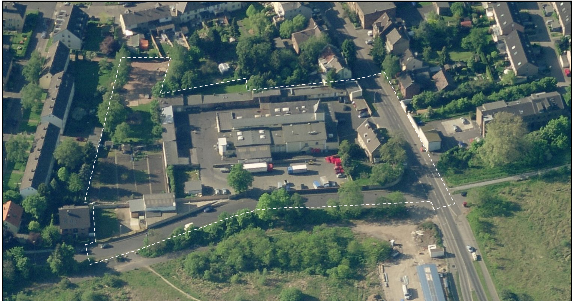
Abb. 3.1.2 Ansicht des Plangebiets vor der Entwicklung (Schlachthofgelände) von Norden
