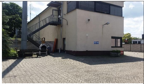
Rückansicht Gebäude A – Verwaltung, Räumlichkeiten hauptamtliche Wachabteilung, Fahrzeughalle Rettungsdienst
