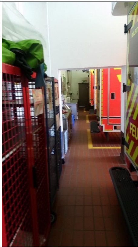
Fahrzeughalle Rettungsdienst – rückwärtige Abstände werden nicht eingehalten
