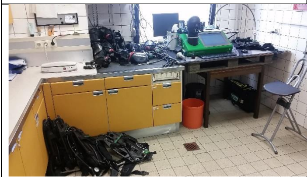
Atemschutzwerkstatt – Platzmangel deutlich erkennbar, Prüfstelle auf improvisierten Tisch
