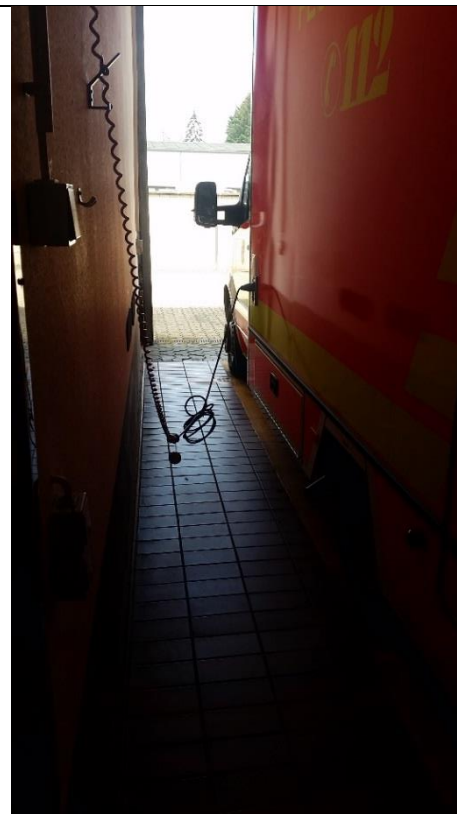
Stellplatz RTW 10 – seitliche Abstände werden unterschritten
