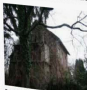
Das Gebäude, das zur Zuckerfabrik gehörte, soll abgebrochen werden. Auch dort sollen Einfamilienhäuser entstehen. Foto: Havlicek
