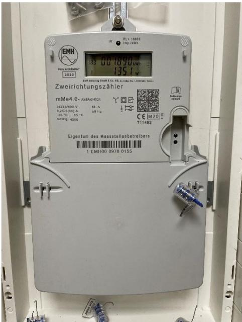
Abbildung 5: Zweirichtungszähler des Pavillon - Nr. 1 EMH00 0978 0155
