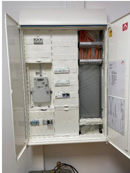
Abbildung 4: Sicherungskasten und Stromzähler des Pavillons
