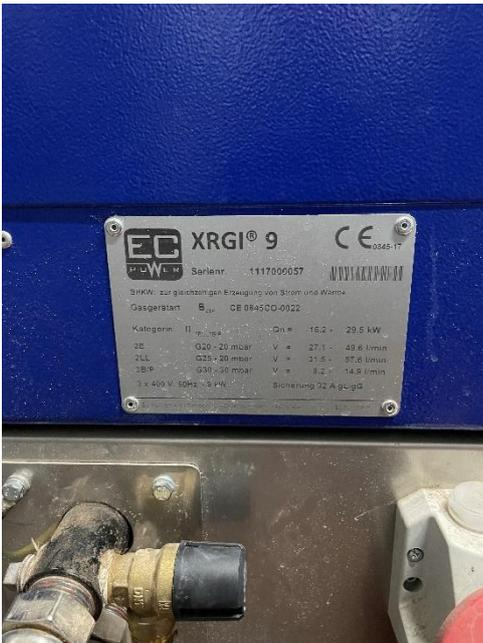
Abbildung 7: Typenschild BHKW
